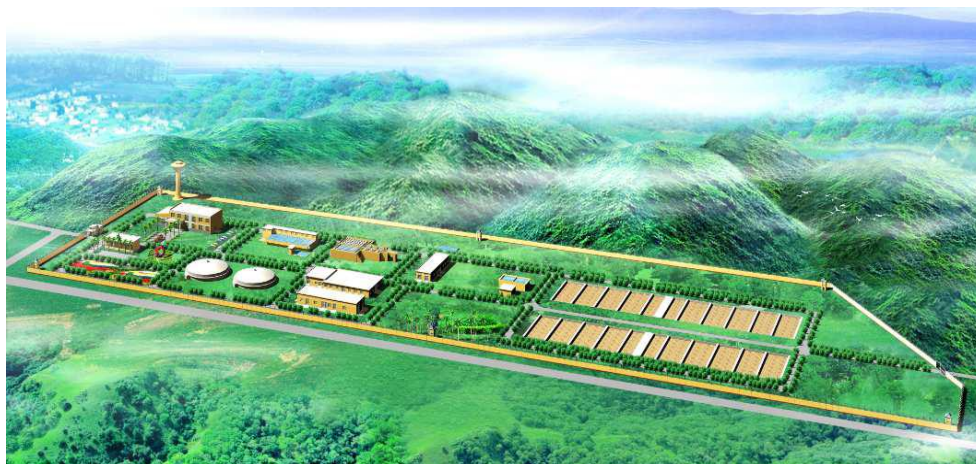
Figure 15: Vue de haut de la station de traitement des eaux potables ; AZZABA, wilaya de SKIKDA (Source : ADE SKIKDA, 2007).
