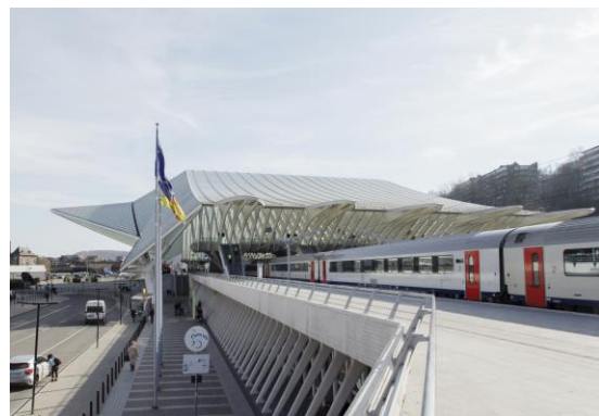
Figure 40 : Vue galerie extérieure
