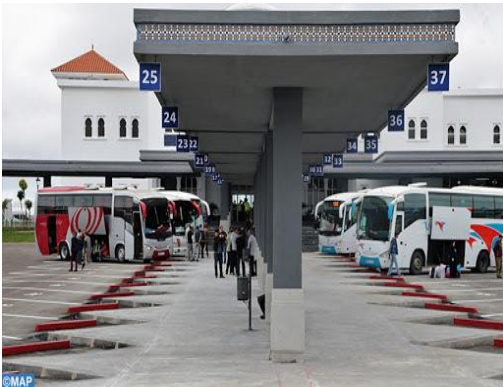
Figure 145 : Gare de Tangerang
