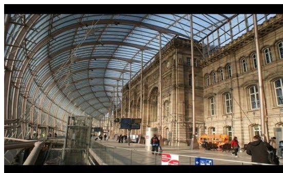
Figure 13 : la gare multimodale de Strasbourg
