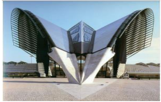
Figure 79 : accès à la gare
