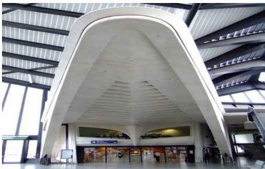
Figure 92 : la structure en porte-à-faux
