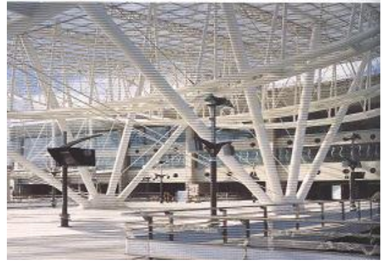
Figure 21 : vue sur la structure de Roissy
