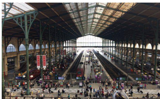
Figure 12 : la gare de paris Nord
