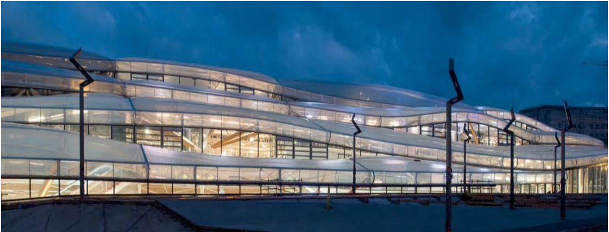
Figure 73 : la toiture en ETFE
