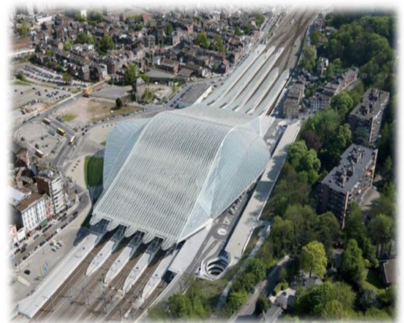
Figure 31 : la gare de Liège
