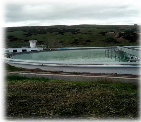
Fig.12. Bassin de décantation (Mars 2022)
