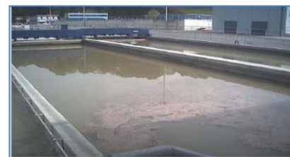
Figure 9 : Bassin de décantation secondaire(2).
