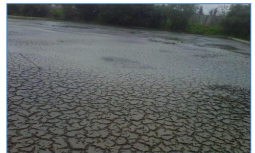
Figure20 : Un lit de séchage (Cerra et Desagnat, 2014).
