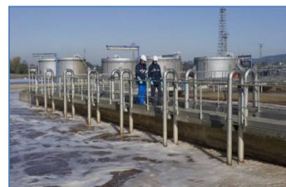
Figure 4: Les eaux usées industrielle(1).
