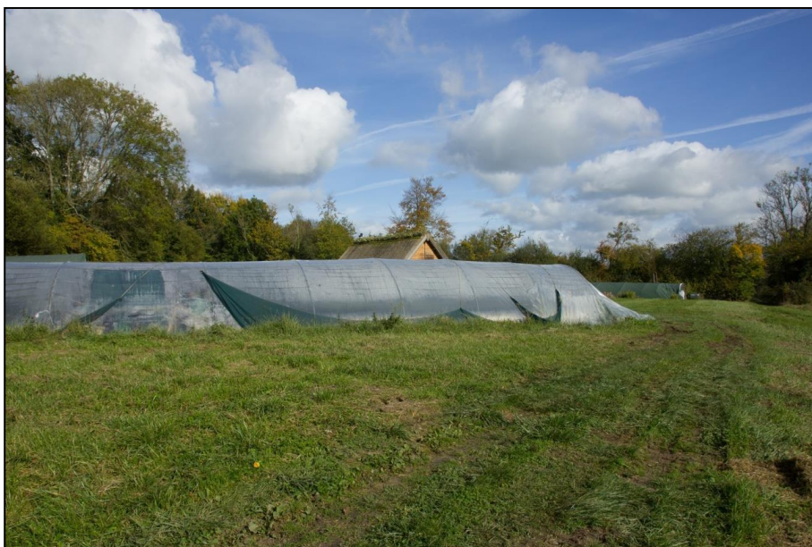
Figure 16 : Bassin de spiruline avec un système d'ombrage (Ahounou, 2018)
