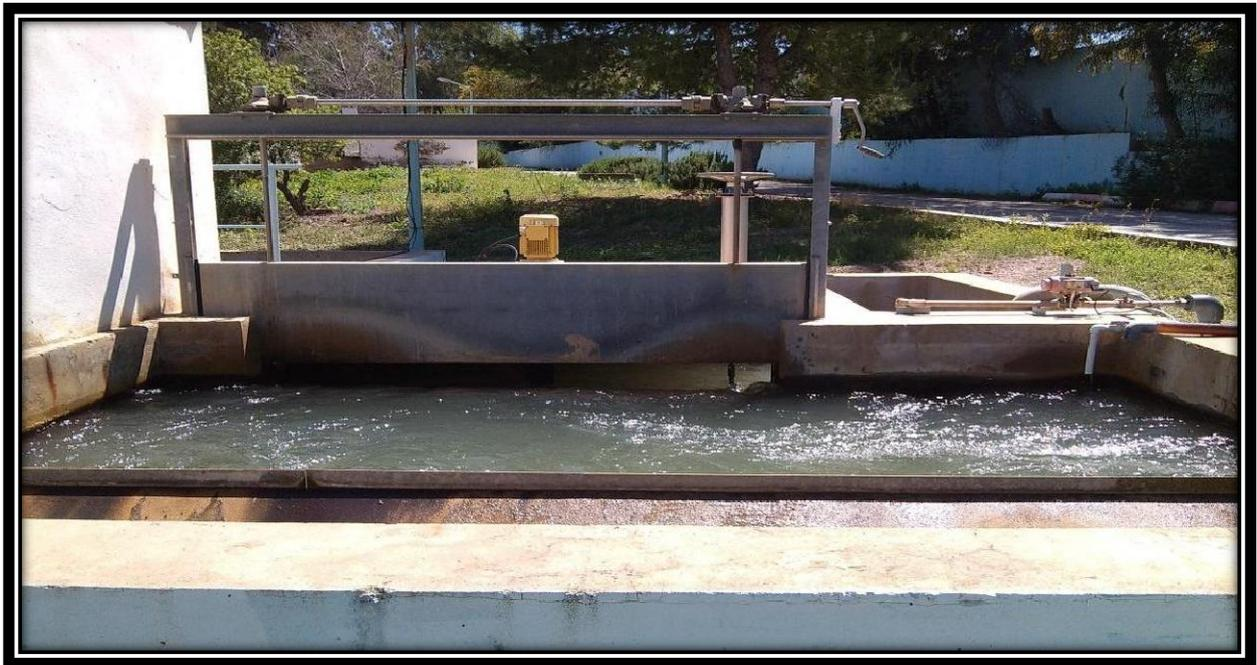
**Figure 14 :** Bassin du pré chloration
