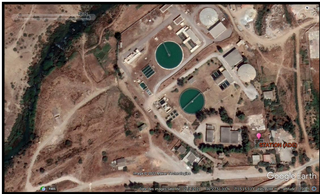
Figure 7: Situation géographique de la station de traitement de Hammam Debagh (ADE) .
