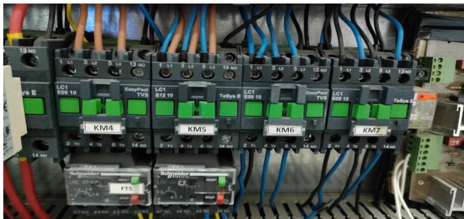
Figure II.13 : contacteur pour les pompes circulation hydraulique et prise alimentation et ventilateur d'aération
