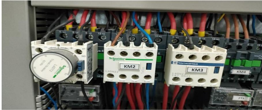
Figure 2.12: contacteur Pour démarrage étoile triangle
