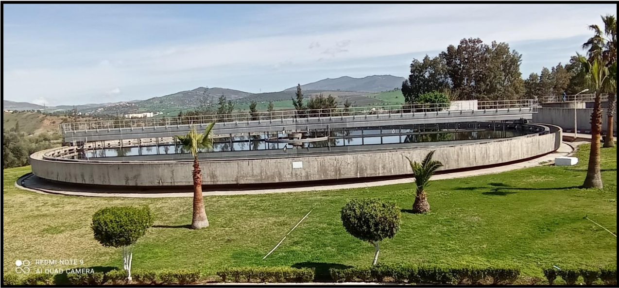
Figure 12 : Bassin de décantation secondaire. (Yassad & Haiahem, 2022).
