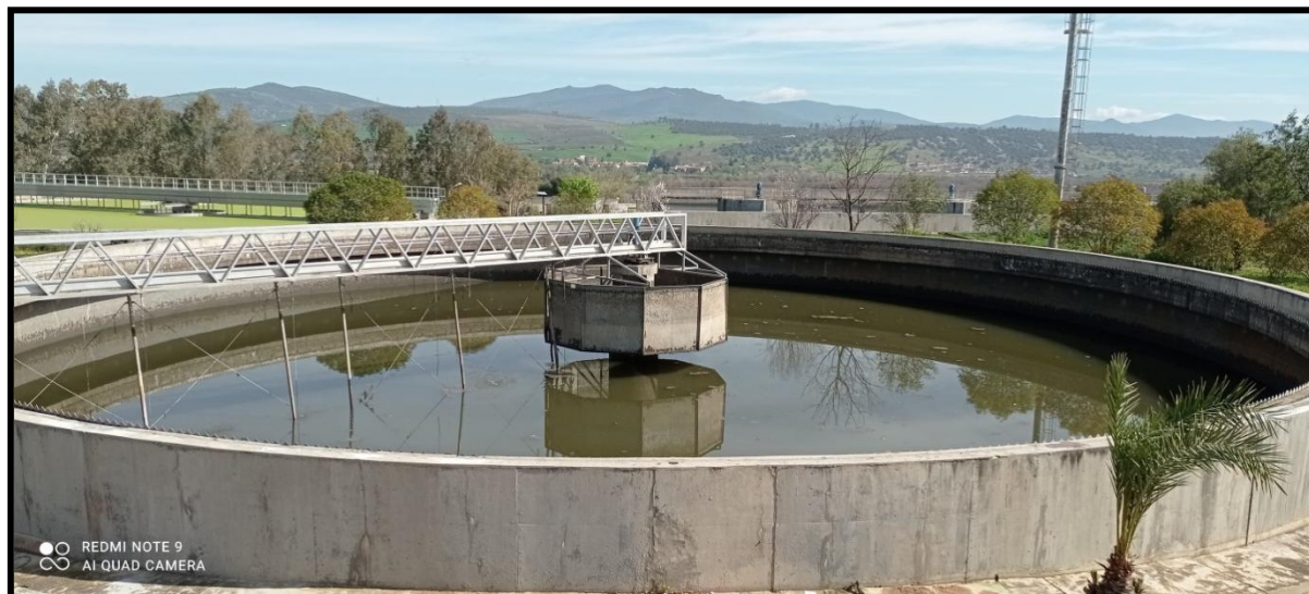
Figure 10 : Décanteur primaire. (Yassad & Haiahem, 2022).
