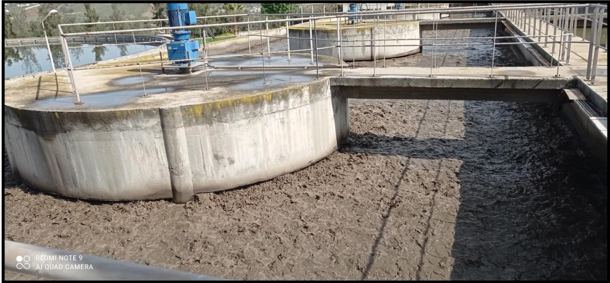
Figure 11 : bassin d'aération. (Yassad & Haiahem, 2022).
