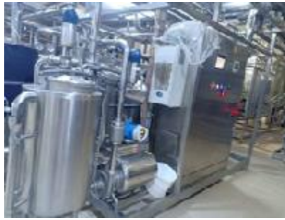
Figure 57. Un dégazeur (Chemmakh et al ; 2022).
