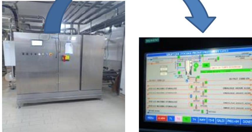
Figure 51. Distribution de lait de vache à tous les cuves (Chemmakh et al ; 2022).
