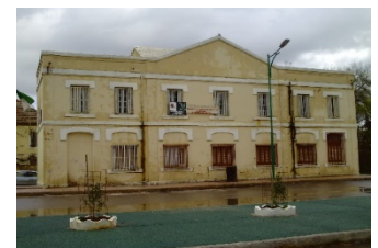
Figure 61: bâtiment de la gare 2
