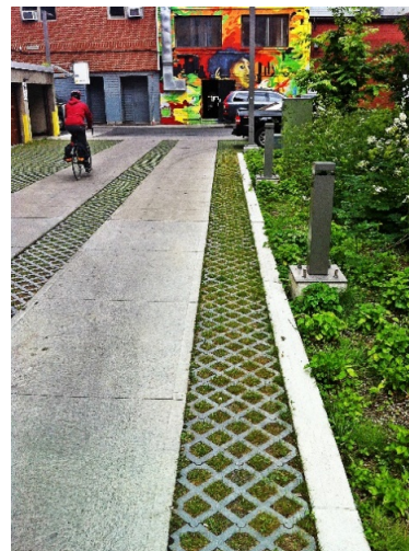
Figure 88: Les Dalles Vertes - Pavage perméable alvéolé fait de plastique recyclé à 100%UNE DALLE. Source :
