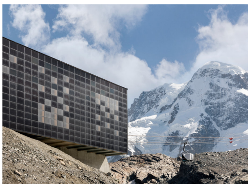
Figure 38: L'installation photovoltaïque téléphérique de Zermatt Suisse
