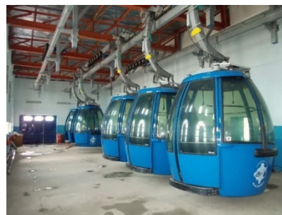
L'ensemble du garage
