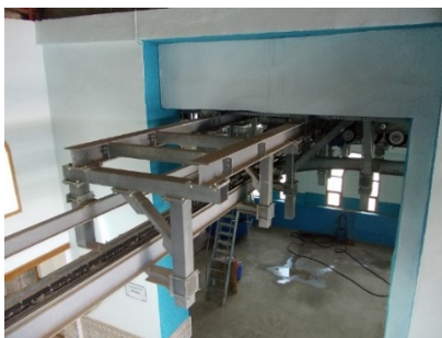
L'accès au garage
