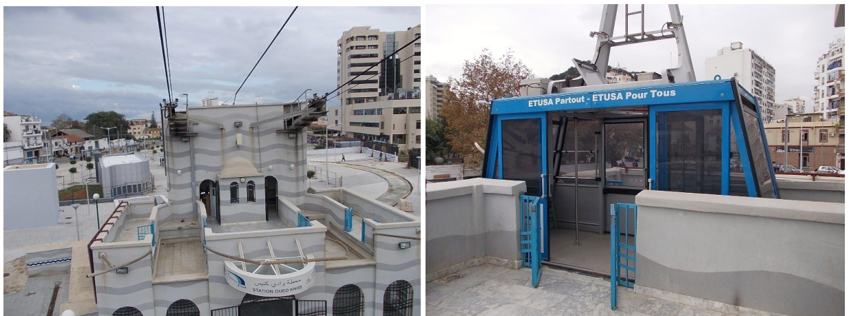
Figure 50: Une cabine à quai.
