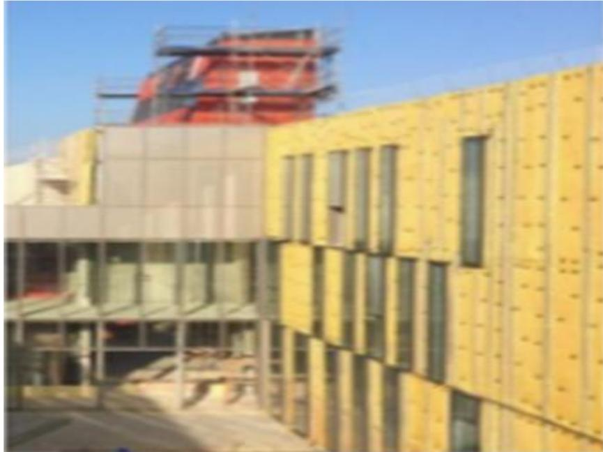
*Figure 28: l'isolation thermique des parois*
