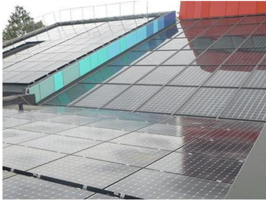
*Figure 23: les panneaux hybrides des toitures des blocs d'enseignement*
