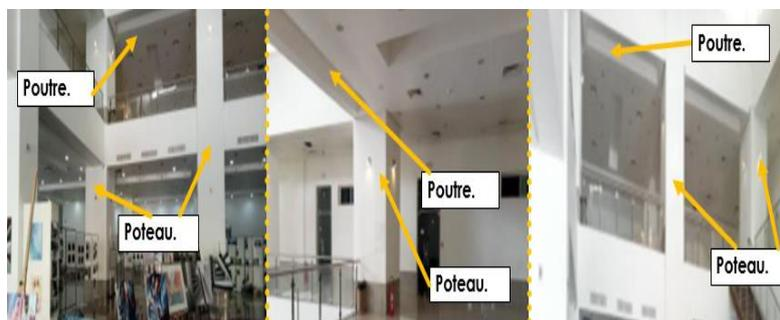
Figure 146 : système constructif du palais de la culture
