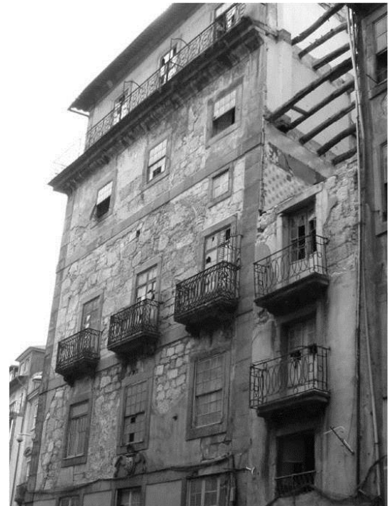
Figure 4 : Bâti dégradé du centre historique
