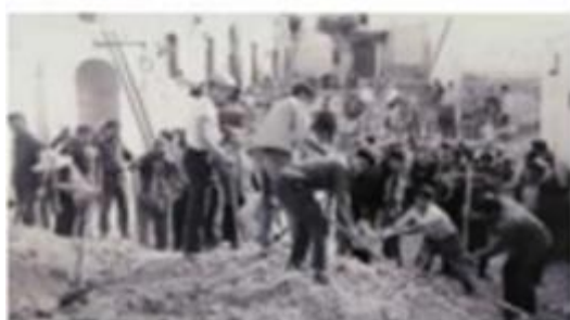
Figure 36 : Travaux de restauration de 1966
