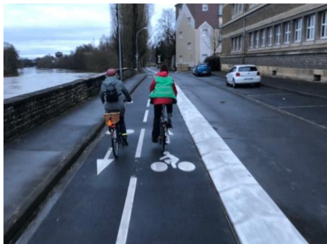
Figure 19 : Séparation avec la chaussée principale.
