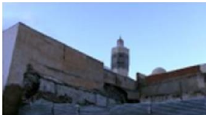
Figure 34 : Démolition de la maison B.Aissa pour bâtir un hôtel de charme
