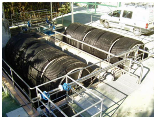
Figure 1-8 : Les disques biologiques
