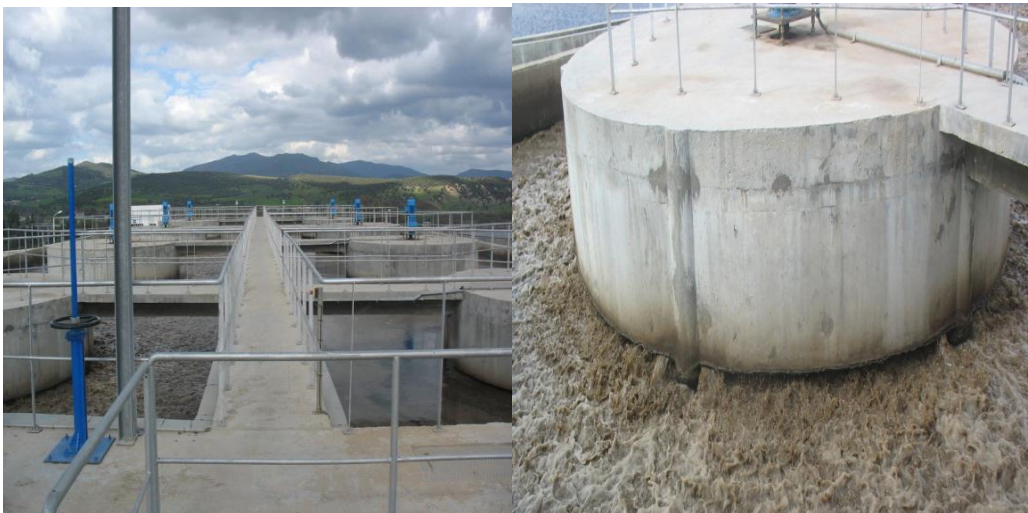
Figure 1-9 : Les deux bassins d'aération accompagnés de leurs 6 turbines (Step Guelma)
