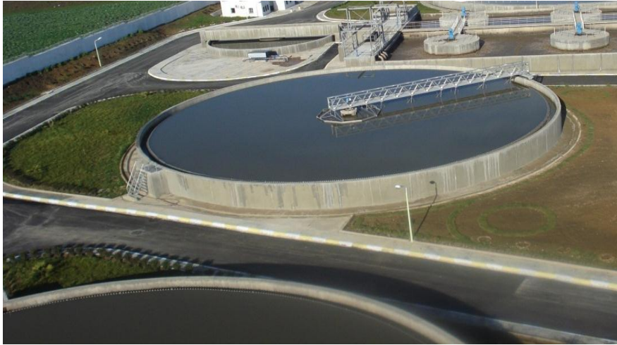
Figure : 1-3 Le décanteur primaire (STEP Guelma)
