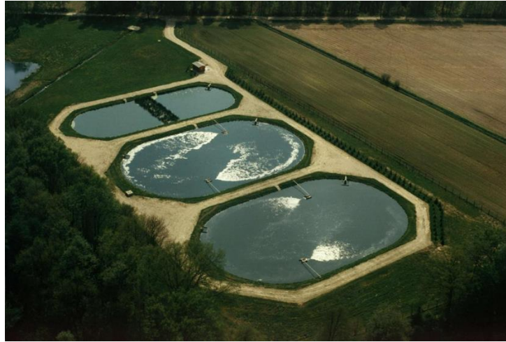
Figure1-4 : le lagunage aéré (Step Guelma)
