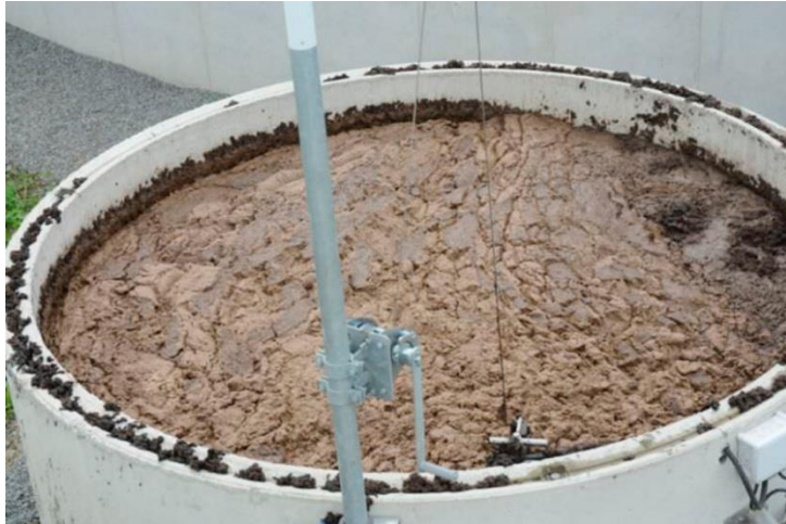
Figure : 1-5 : Les boues activées
