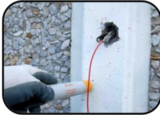
Figure I.8 : Mesure du potentiel de corrosion
