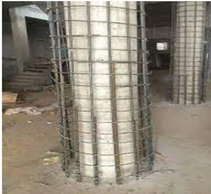
Figure II.1 : Chemisage en béton armé
