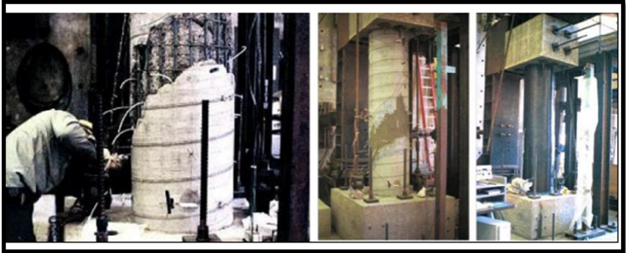
Figure II.7 : Traitement et renforcement par PRFC
