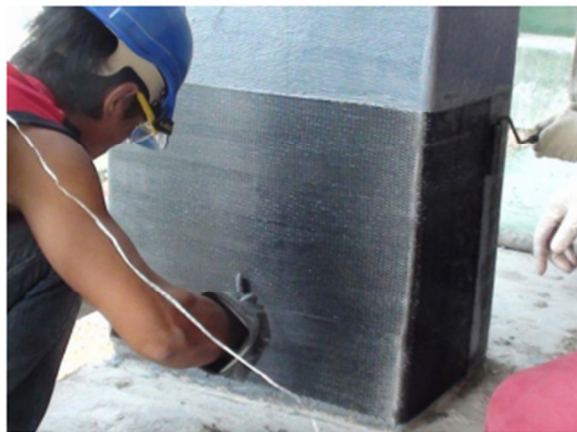
Figure II.11 : Chemisage en fibre d'un poteau
