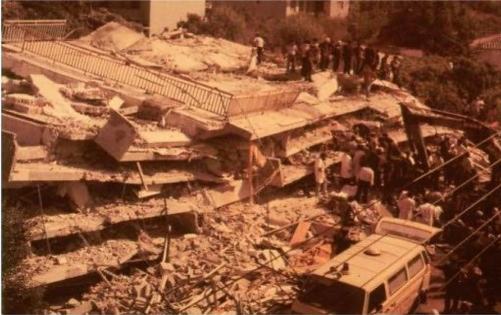
**Figure 2.1** Effondrement total des constructions non ou mal contreventées :
