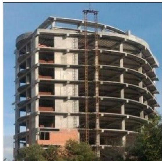
Ossature contreventée par voiles en béton armé. [7]
