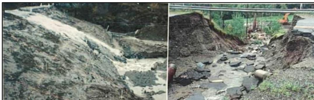
Fig. 19 Phénomène d'érosion dans les remblais
