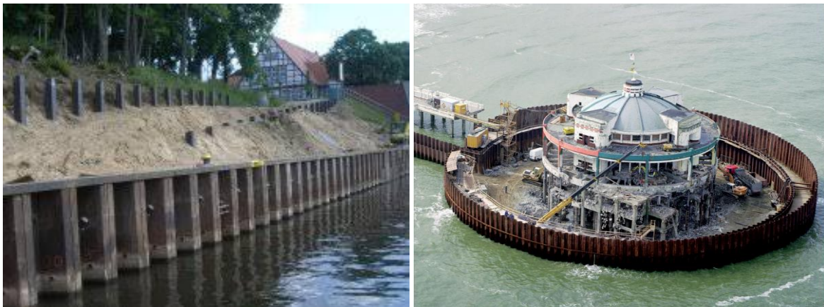
Figure I.28 : Les rideaux de palplanches [13].
