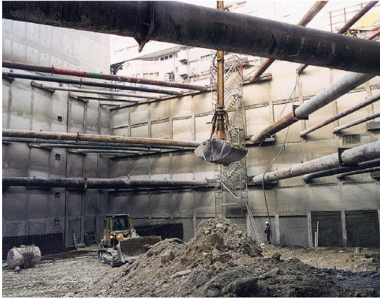
Figure I.18 : Renforcement par butons.
