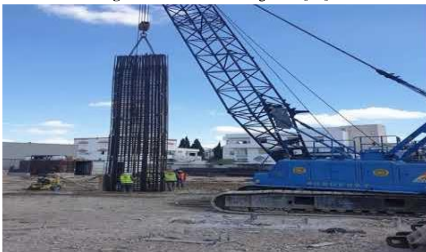
Figure I.7 : Mise en place d'une cage d'armatures [19].
