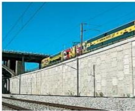
a : ouvrages ferroviaires
