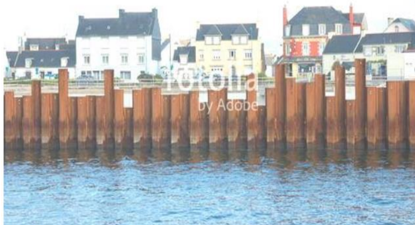
Figure I.30 : Mur en palplanche [13].
