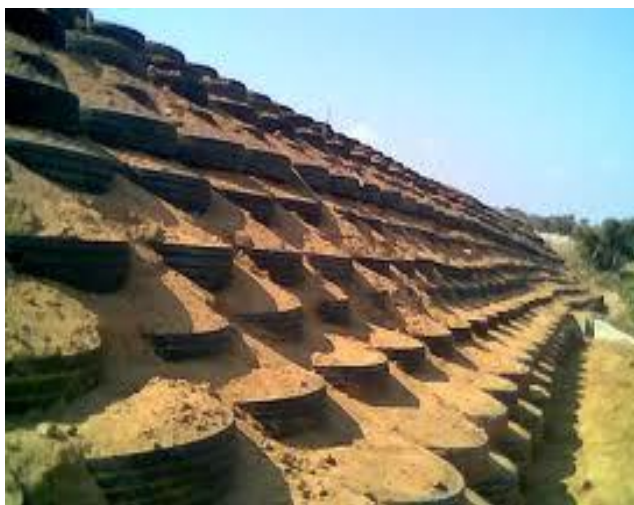
Figure I.13 : Mur en pneu sol.
