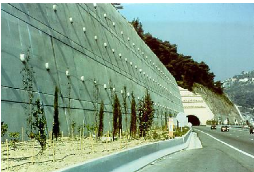
Figure I.9 : Exemple de mur cloué [13].
