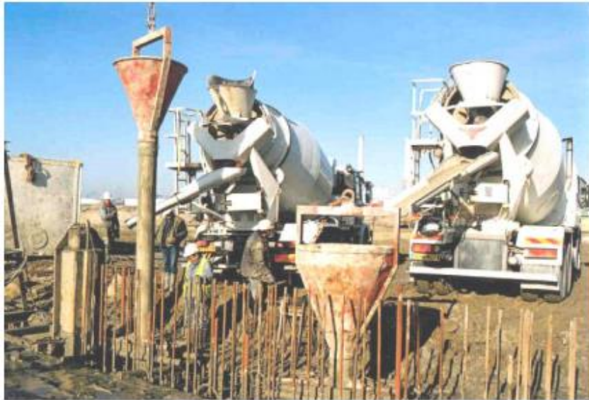
Figure I.8 : Bétonnage d'un panneau.
