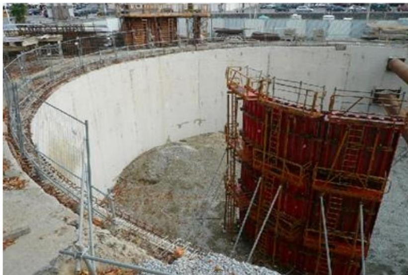
Figure I.3 : mur en parois moulées [18].
