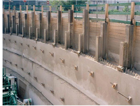
Figure I.19 : Renforcement par tirants.
