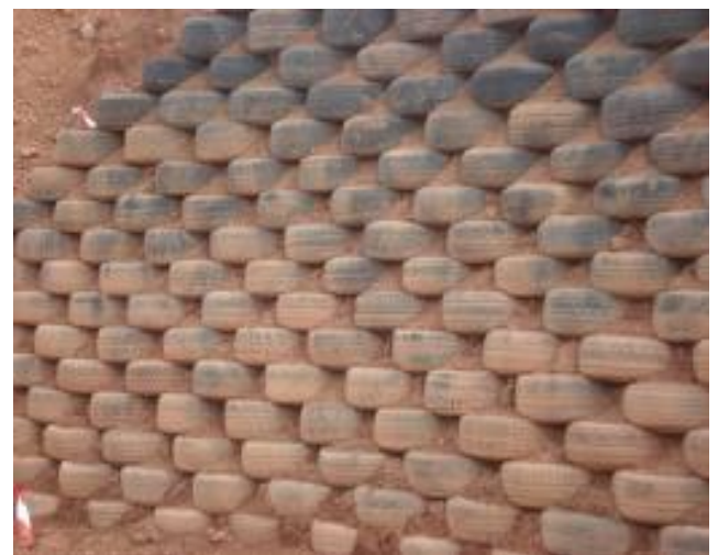
Figure I.13 : Mur en pneu sol.
