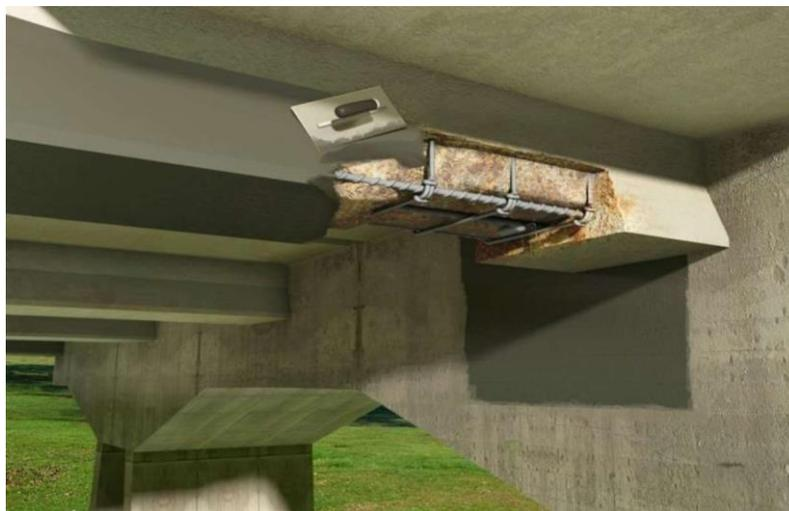
Figure I. 5. Mortier de réparation (Net, I.5)
