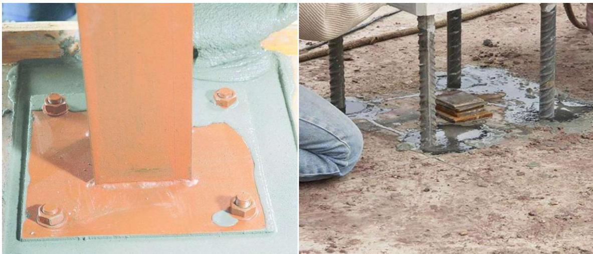
Figure I.3. Mortier pour scellement et calage (Net, I.3)
