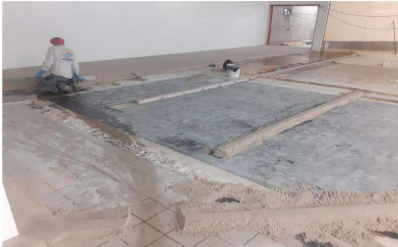
Figure I. 2 Mortier pour chapes (Net, I.2)
