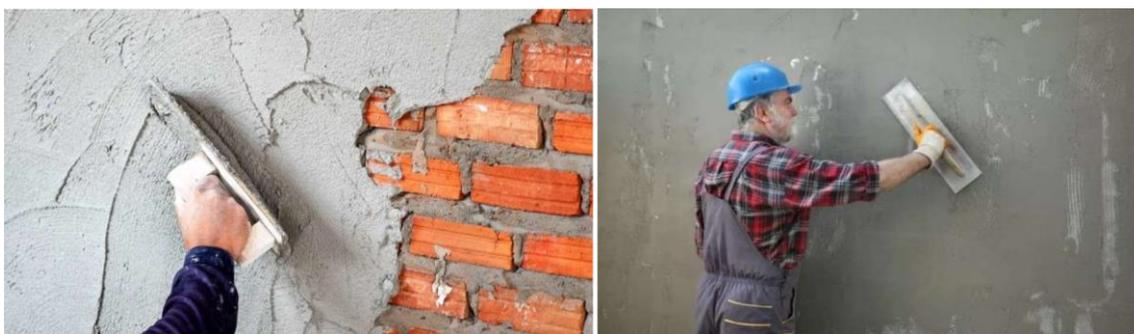
Figure I.6. Mortier de revêtement (Net, I.6)
