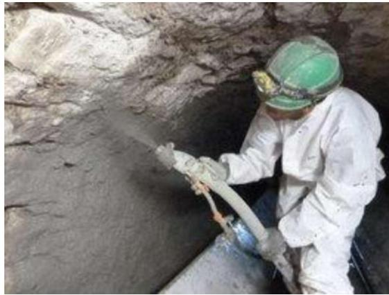
Figure I.4. Mortier projeté (Net, I.4)
