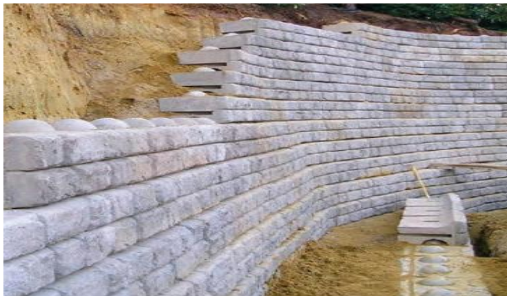
Figure I.3 : les murs poids.
