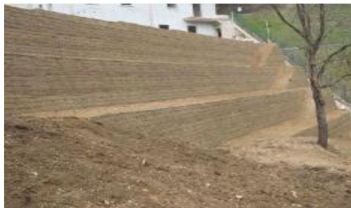
Figure I.8 : Mur en sol renforcé.
