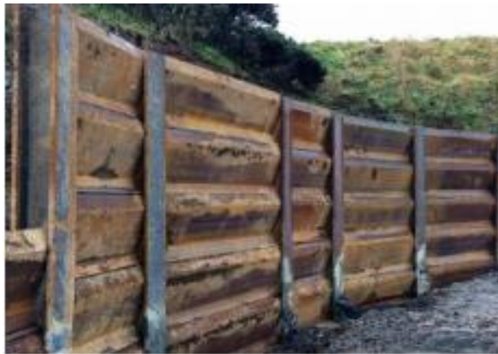
Figure I.6 : Rideau de palplanches métalliques.
