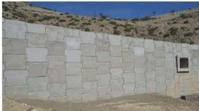
Figure I.9 : Mur en terre armée.
