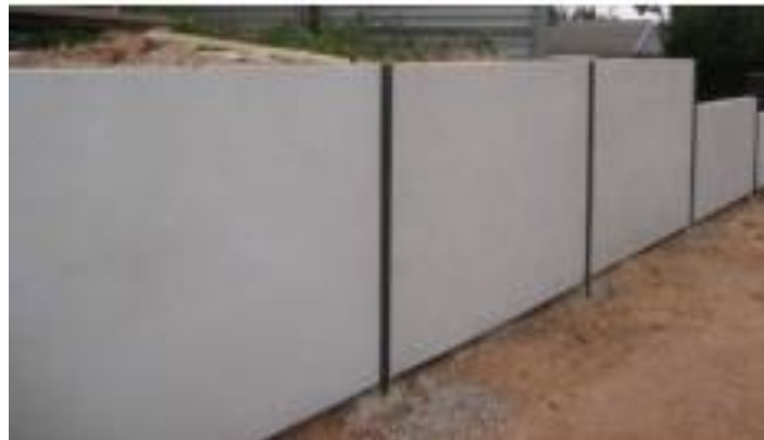
Figure I.7 : Paroi en béton.
