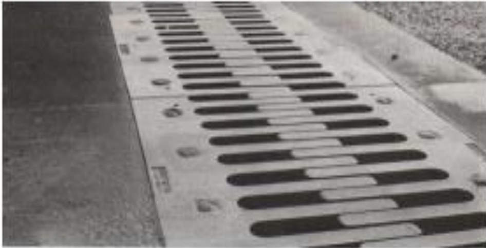
Figure VIII.6 : Joint de la chaussée.
