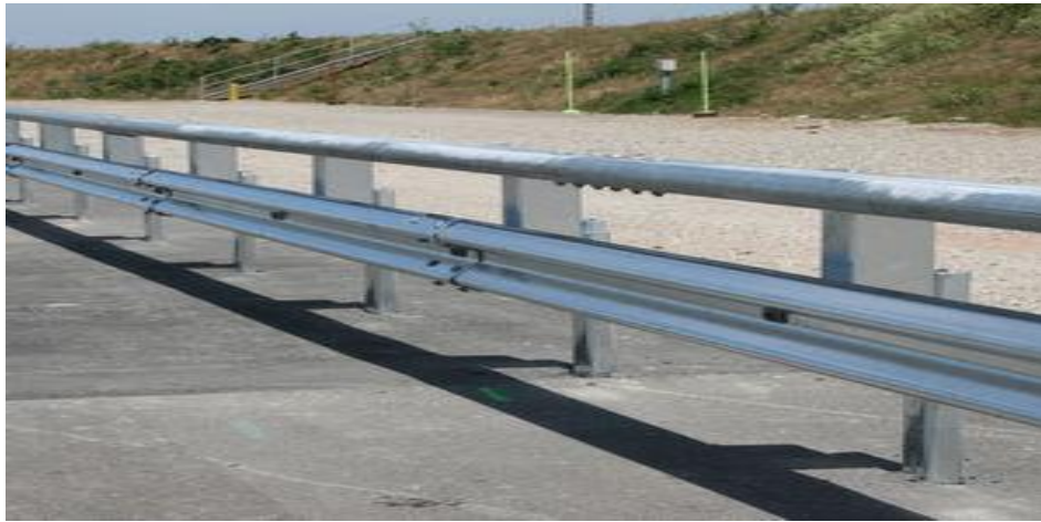
IV.5. Figure VIII.9 : Glissières de sécurité.
