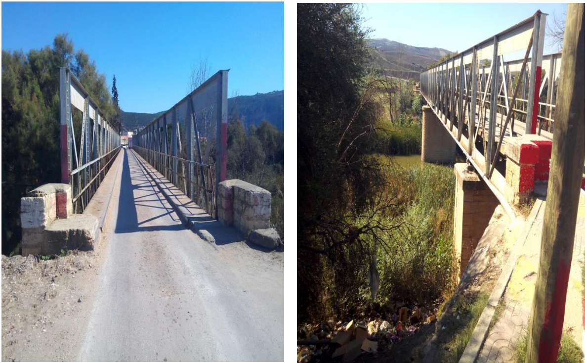
Figure II.2 : Ancien pont métallique
