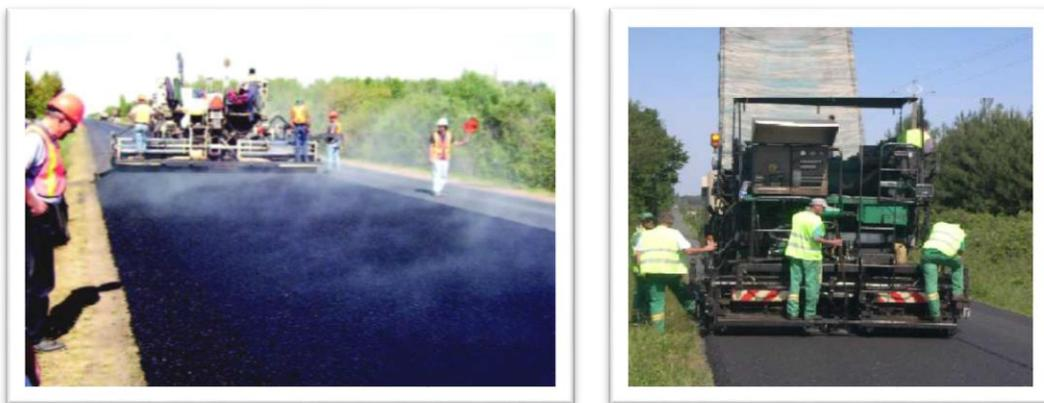
**Figure III.7. :** Technique de l'asphalte caoutchouté.
