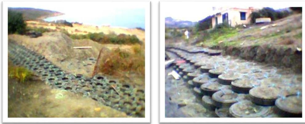
**Figure III.6 :** Stabilité d'un glissement de terrain - Cas de Tizi Ghenif – Wilaya de Tizi Ouzou Algérie.
