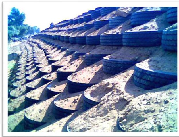
**Figure III.5 :** Pose des nappes de pneus Projet pilote – Route de Bousmail.
