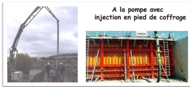
Figure I.3 : Exemples de mise en œuvre des BAP.
