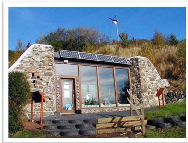
Figure III. 8 : Exemple d'utilisation des caoutchoucs recyclés.
