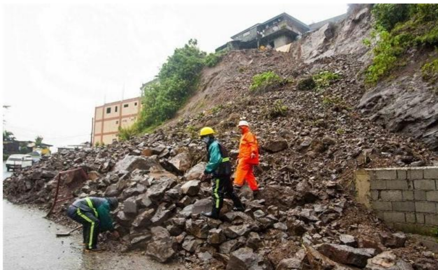
Figure I.20 : Glissement de terrain en Philippine.
