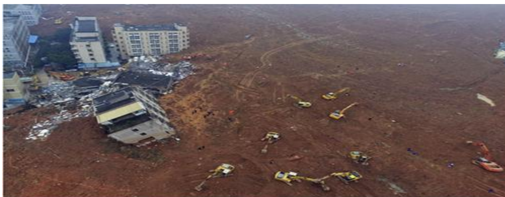
Figure I.15 : Un glissement qui a provoqué une explosion de gaz en Chine.
