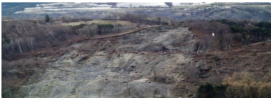
Figure I.18 : Un glissement rotationnel de l'Adverseil sur la commune de Corps.
