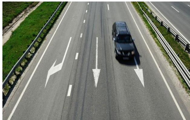
Figure III-13 : Flèche de section
