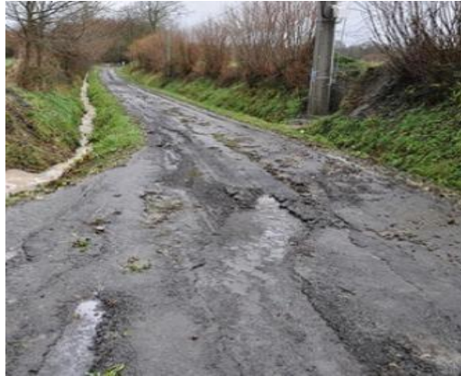
Figure III- 2 : Affaissement
