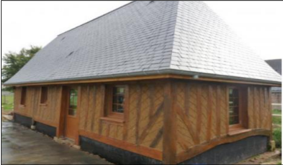
Figure 2.9 Construction d'une maison en colombage et torchis près de Rouen, France. [9]
