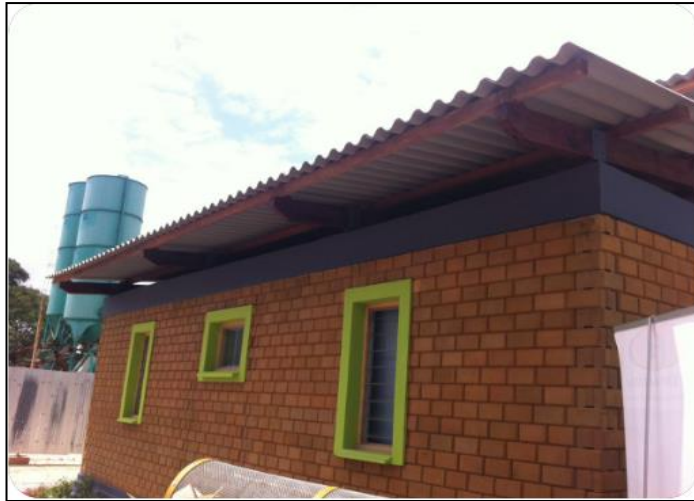
Figure 2.12 Maison en BTC, photos d'Abidjan, Côte d'Ivoire. [13]
