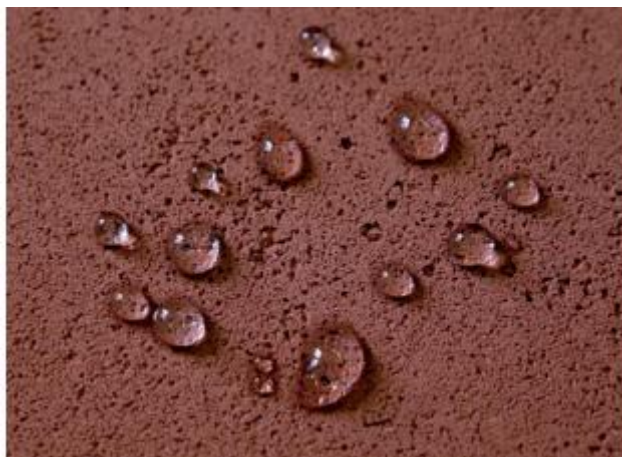
Figure 3.44 Gouttes d'eau sur un enduit de terre rouge au blanc d'œuf. [38]
