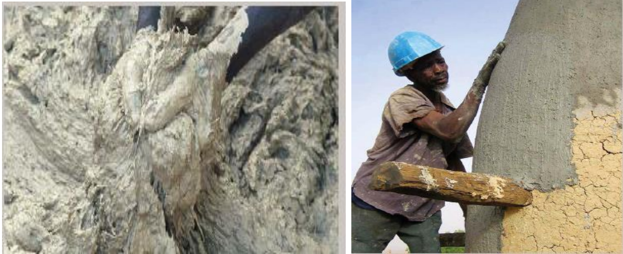
Figure3.20 Restauration de la Grande Mosquée de Mopti(Mali). [30]
