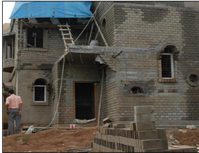
Figure 2.13 Construction en blocs de terre compressée stabilisés (BTC) à Bangalore, Inde. [9]
