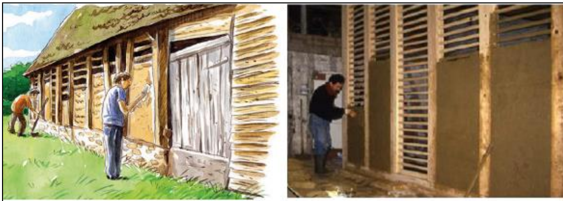
Figure 2.8 Technique de la construction en terre : Torchis. [9]
