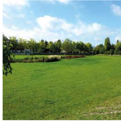
Bassin de rétention paysager
