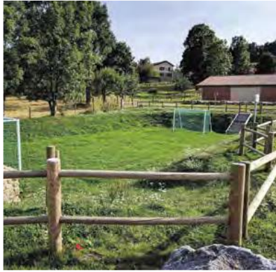
Bassin de rétention multi-usages
