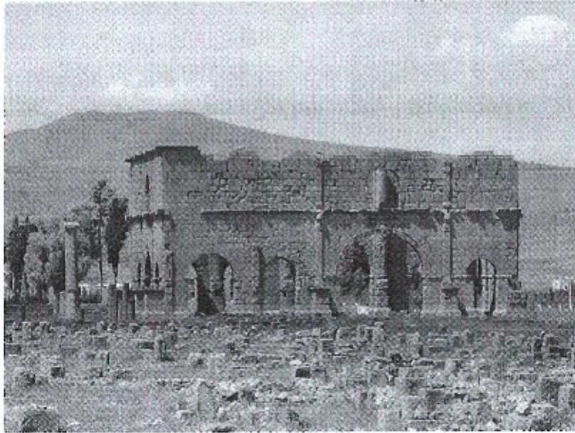
صورة لمبنى القروما بمدينة لمبيزس
