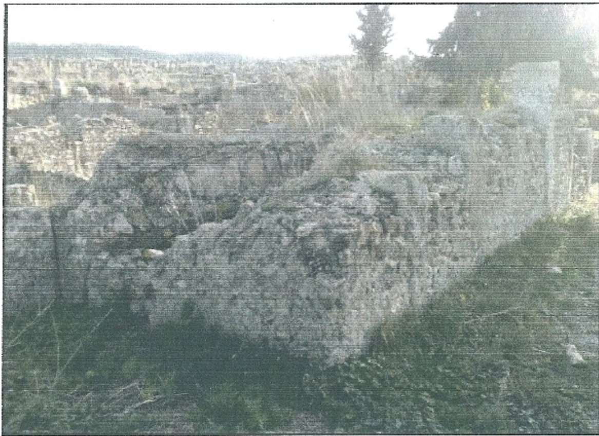
الصورة 18: الشكل الخارجي للخزان المجاور للحمامات الشمالية الكبرى
