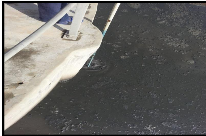
Figure 12 : Le bassin de prélèvement des boues liquides : bassin de stabilisation.
