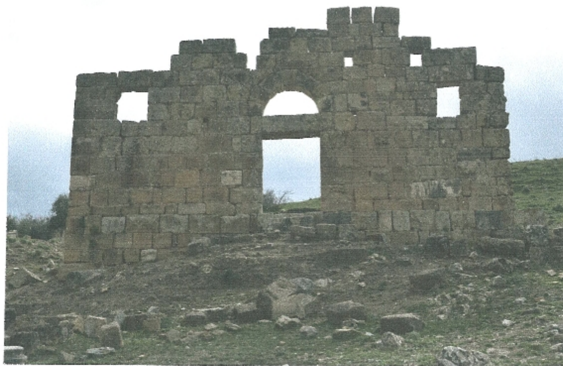
الصورة رقم (2) : توضح الواجهة الأمامية (المدخل الرئيسي - النوافذ - الفتحات - العقد)
