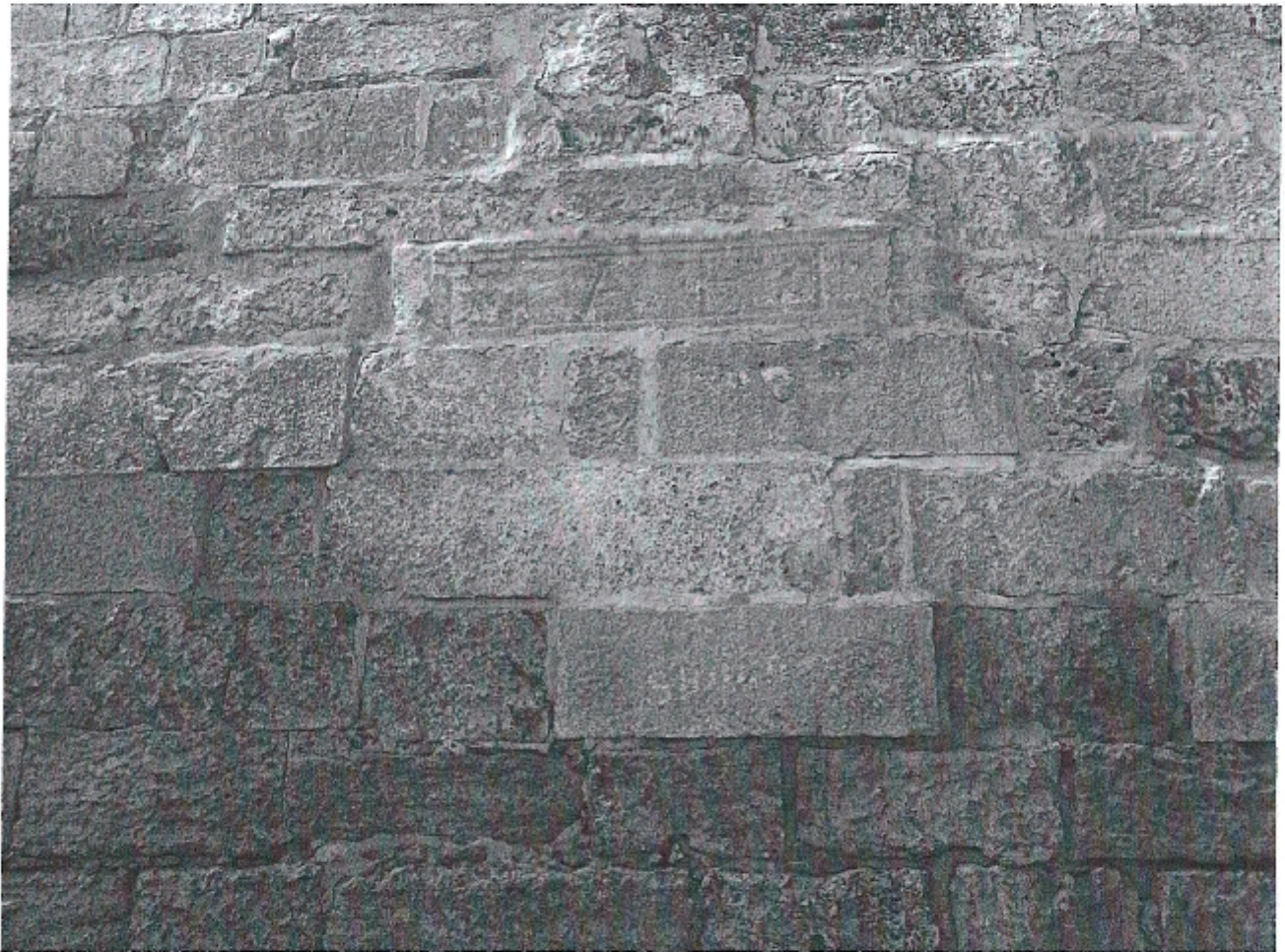
الصورة رقم 3: تقنية الرصف
