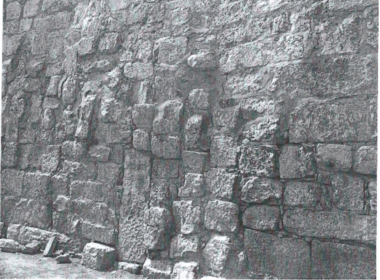
الصورة رقم 27 : تبين وضع الحجارة في وضعيات وأحجام مختلفة
