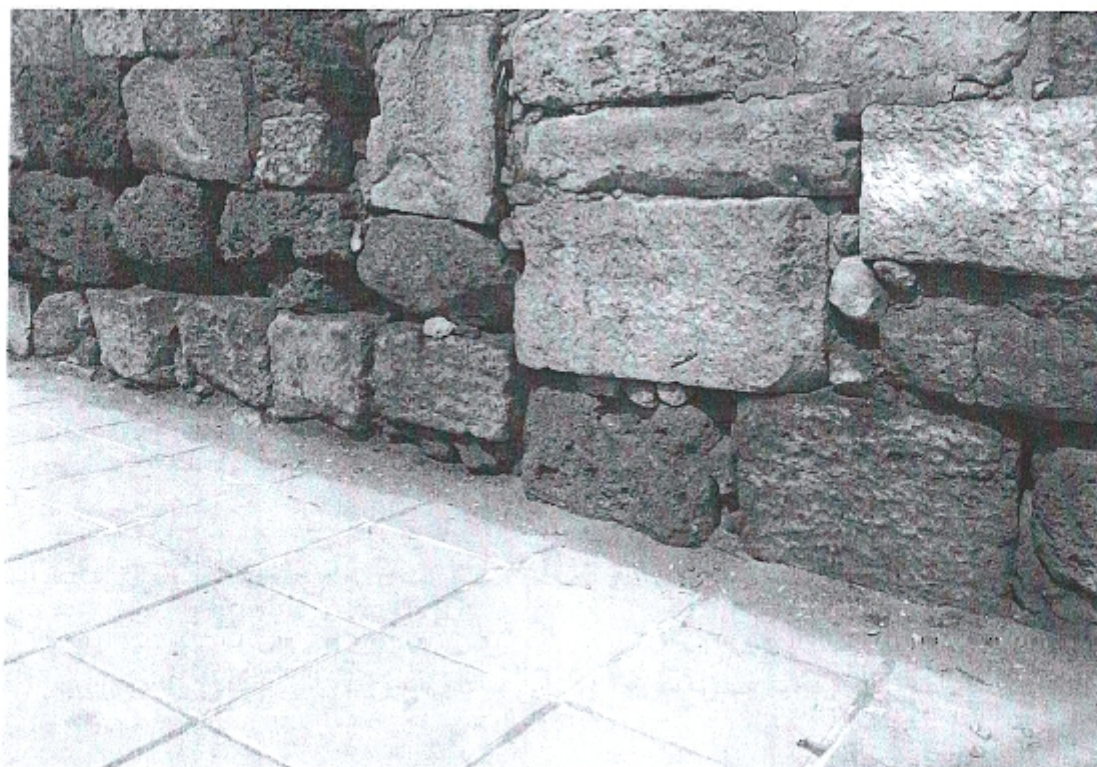
صورة رقم 06: صورة تبين استعمال الدبش في السور
