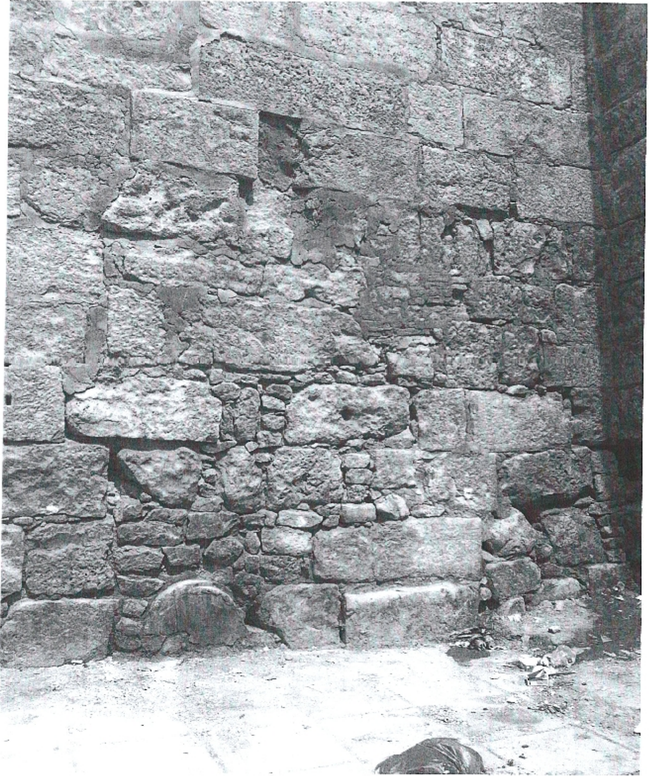
الصورة رقم 26 : صورة تبين ملئ الفراغات بالحجارة من مختلف الأحجام
