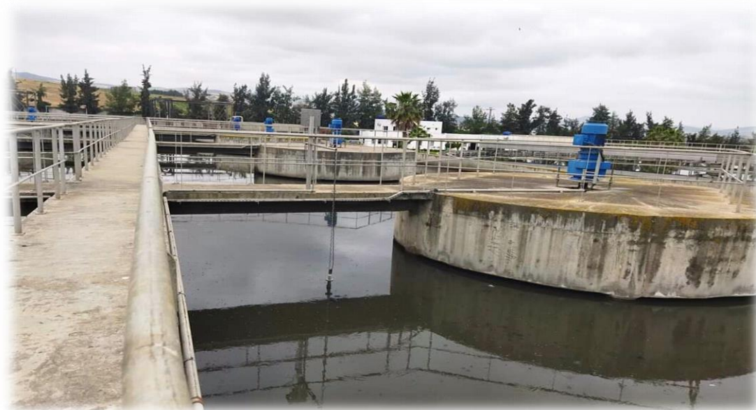
Figure II.6 : Bassin d'aération (STEP Guelma 2021).
