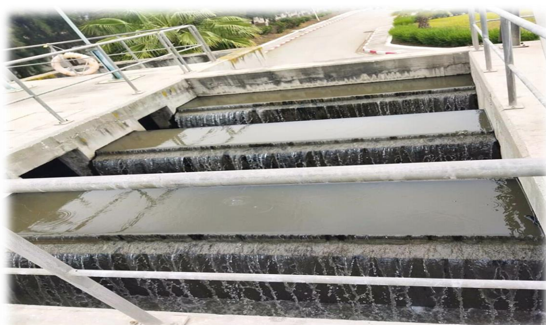
Figure II.4: Dessablage et déshuilage (STEP Guelma 2021).
