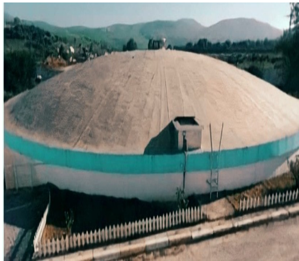
Figure I.III.8 : Réservoir pour stockage d'eau potable
