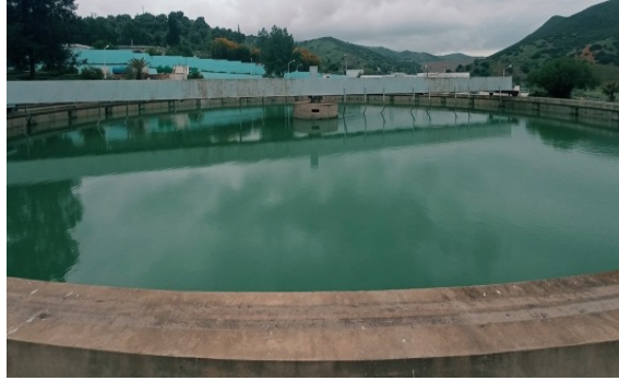
Figure I.III.6 : Bassin de décantation.
