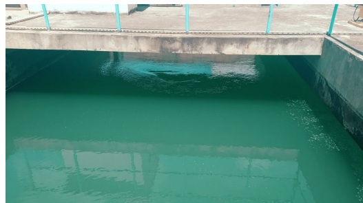
Figure I.III.4 : Bassin de floculation (agitation lente).
