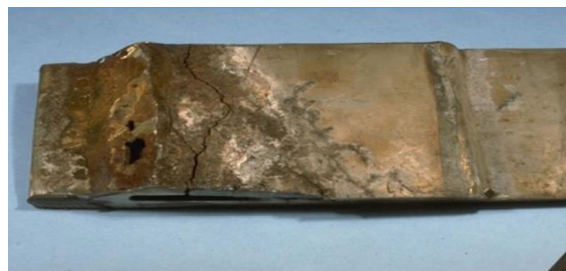
Figure I.9. La corrosion sous contrainte [9]
