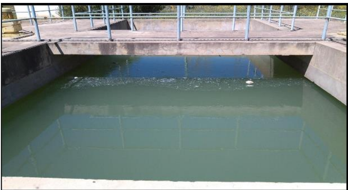
Figure 2.6 : Représente le bassin de floculation
