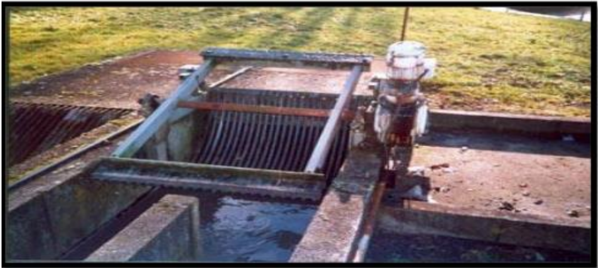
Figure 2.2 : Schéma d'un dégrilleur
