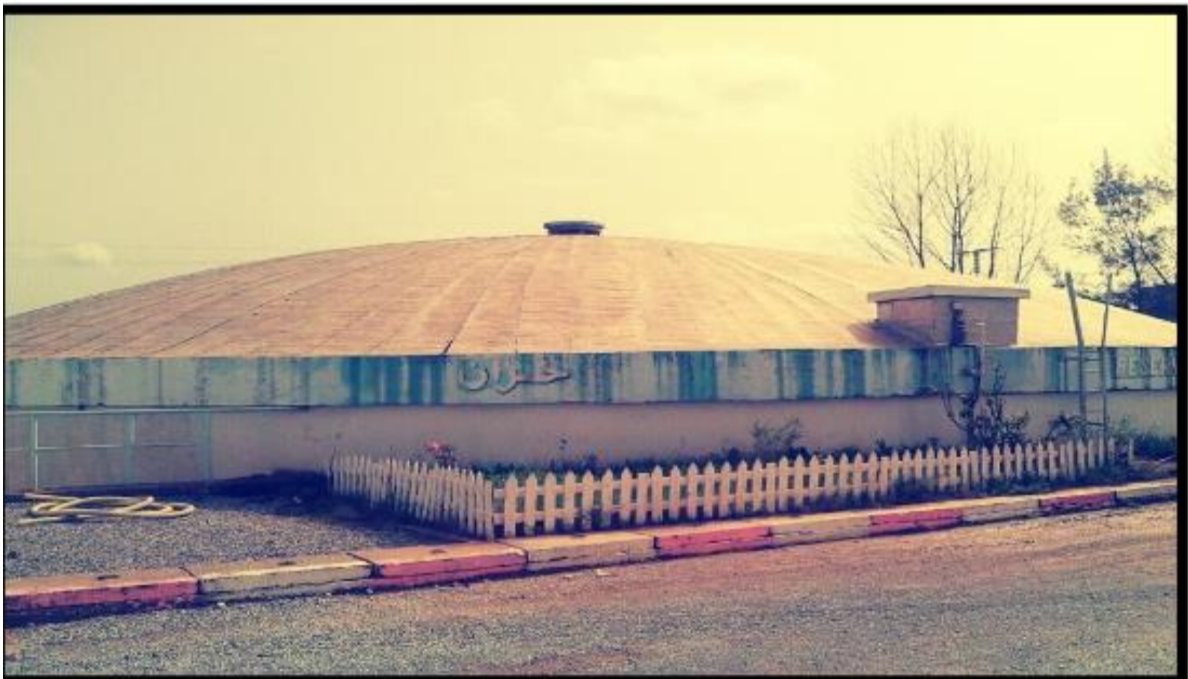
Figure 2.10 : Le réservoir de stockage
