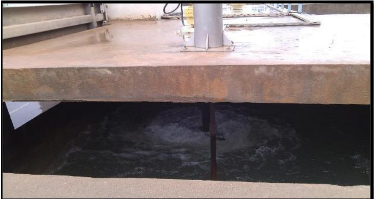
Figure 2.5 : Représente le bassin de coagulation.
