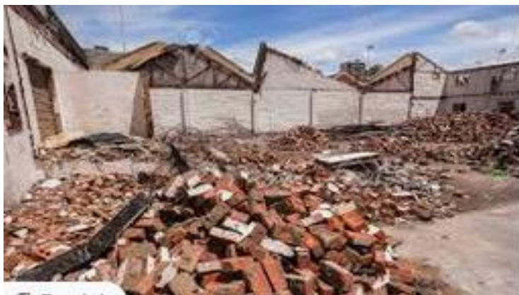
Figure. III.2 Démolition d'un bâtiment en brique [5]
