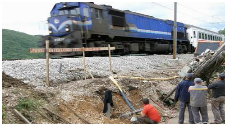
Figure II.7 Amélioration d'un remblai de chemin de fer
