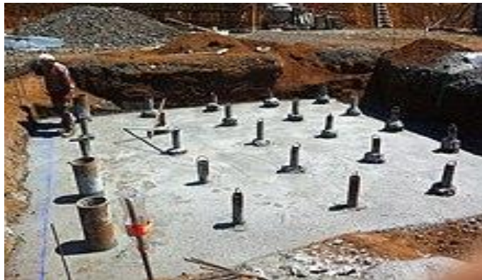
Figure I. 3 Renforcements par des micro-pieux [17]
