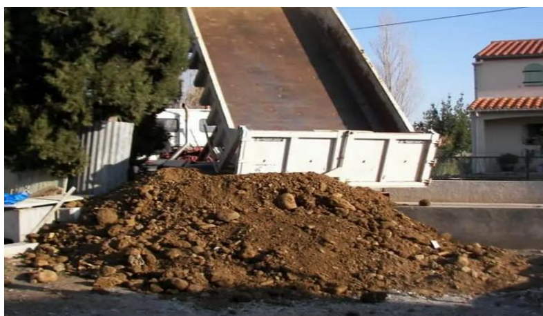
Figure II.8 Stockage d'un matériau excédentaire à un dépôt
