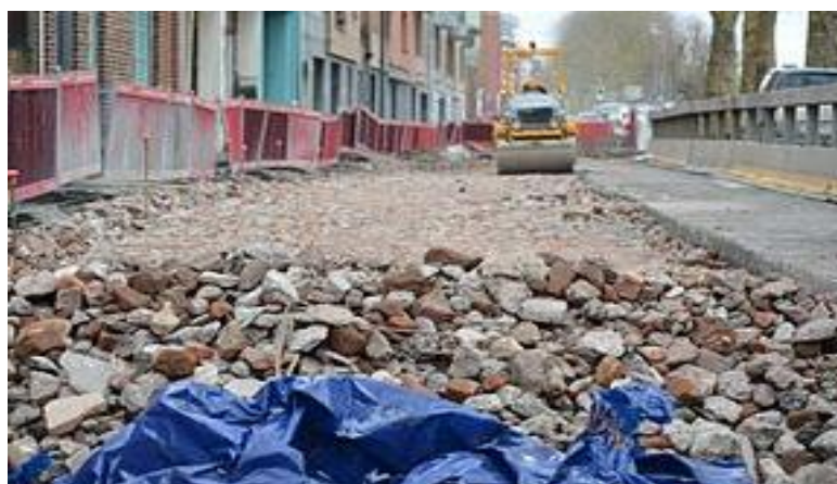
Figure. III.5 Utilisation du gravât en fond de couche routière [17]
