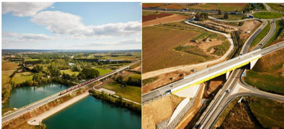
Figure II.1 Types des remblais (ferroviaire, routière)
