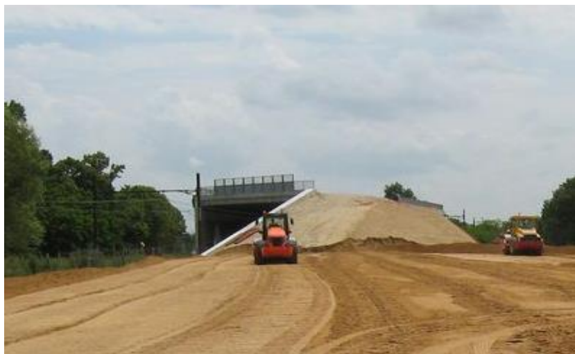
Figure II.4 Mise en œuvre d'un remblais contigus d'un ouvrage
