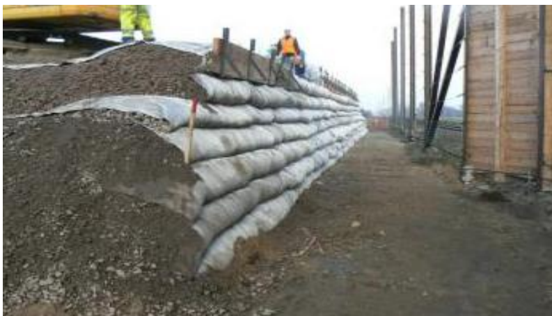
Figure II.9 Le renforcement d'un remblai
