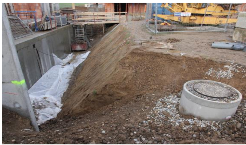
Figure. II.17 Mise en œuvre d'un dispositif de drainage
