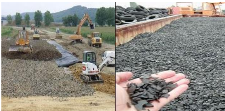
Figure. III.10 Utilisation de copeaux de pneus en remblai routier [23]
