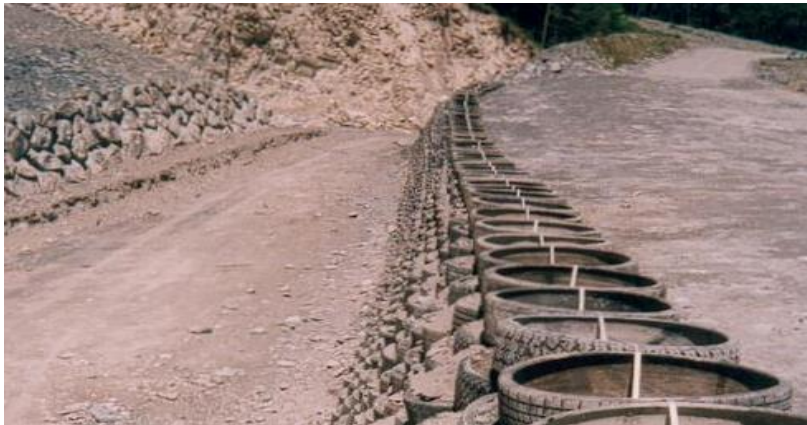
Figure II.10 Réalisation de la route avec la technique de remblais pneusol
