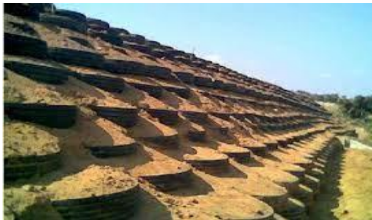
Figure I.11 Stabilisation d'un remblai par le pneusol
