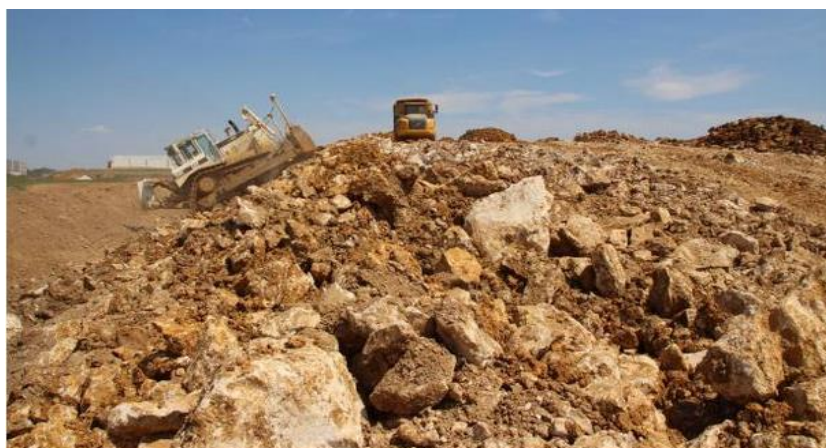
Figure II.3 Remblais pour terrassement routier
