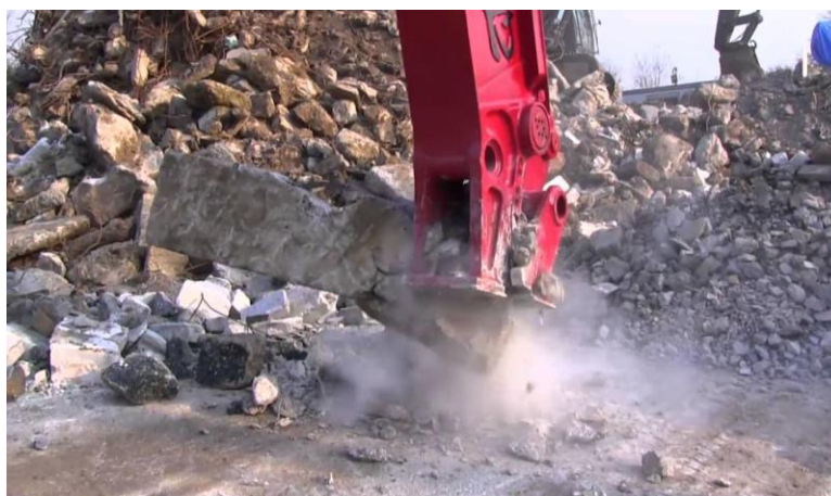
Figure. III.1 Le broyage du béton [34]
