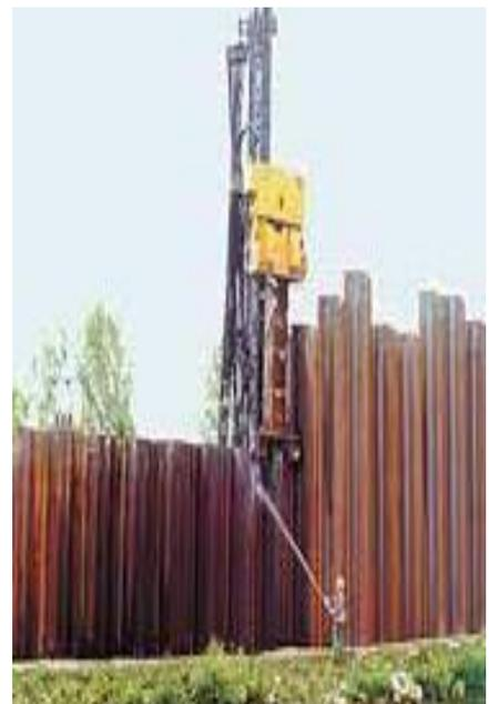
Figure I. 7. Fonçage d'un Rideaux de palplanches
