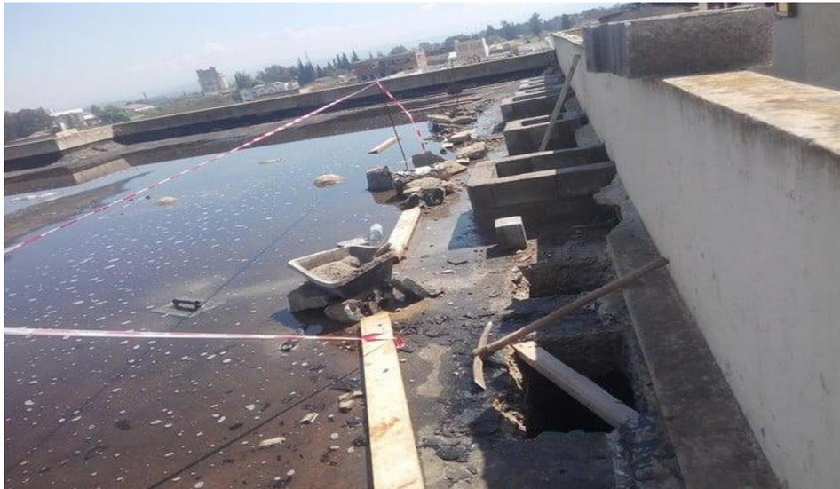
**Figure V.9 :** Détachement des couvres joints des façades.
