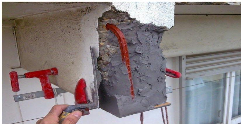
**Figure I.2** : Réparation de béton.
