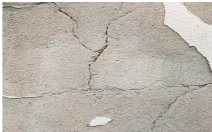
**Figure V.6 :** Fissures et chutes des enduits de revêtement, déformation des faux plafonds.
