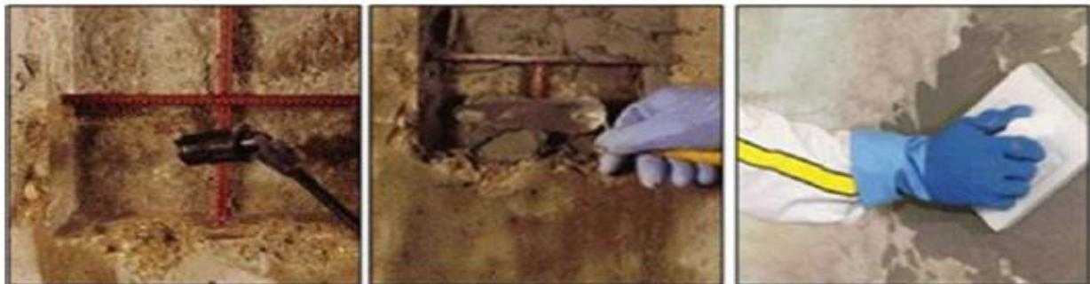
**Figure III.1 :** Aciers dégagés, Application du mortier et finissage par taloche. [J.A.2016]
