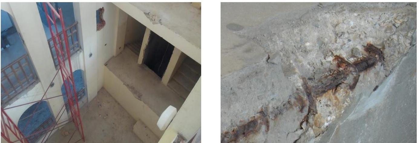
**Figure V.8 :** Dégradation du béton.
