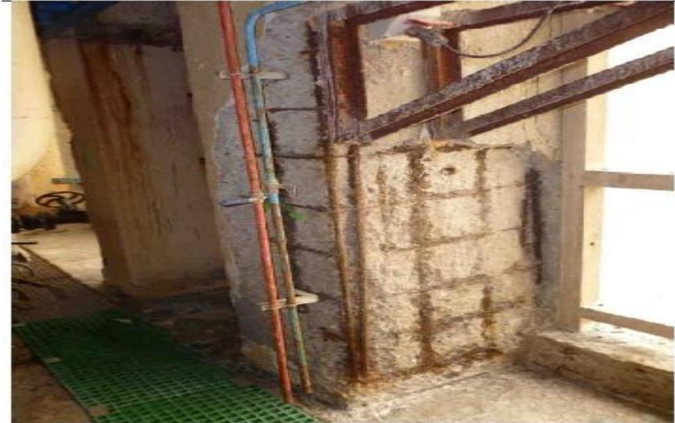
**Figure I.9 :** Dégradation due à la corrosion.
