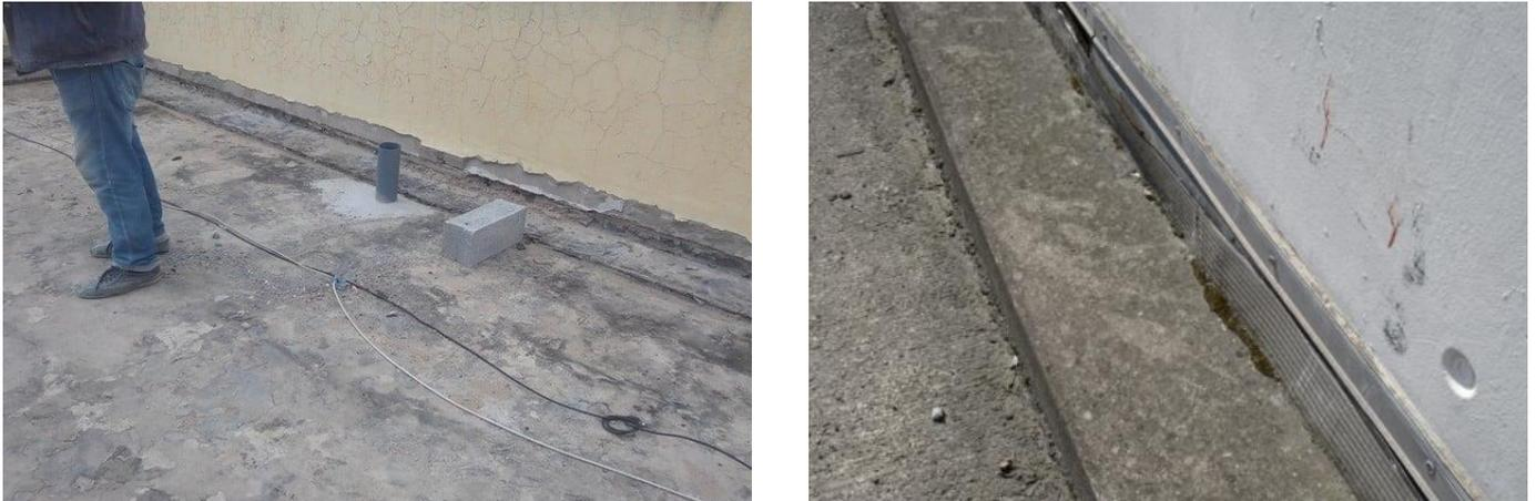
**Figure V.7 :** Détérioration des complexes d'étanchéités des terrasses inaccessibles.
