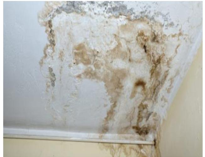
**Figure V.5 :** Trace d'infiltration d'eau.
