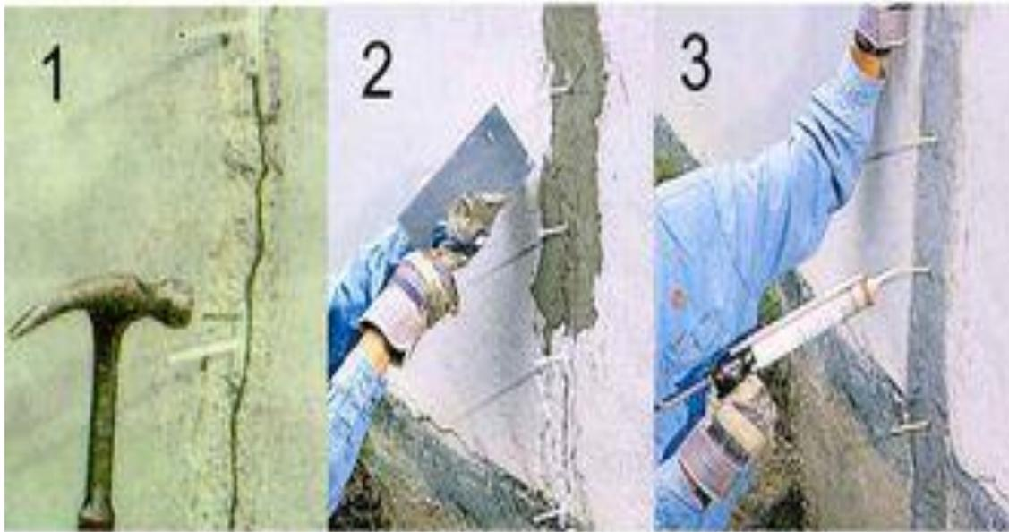
**Figure III.6 :** La réparation d'une fissure à l'aide d'une injection.
