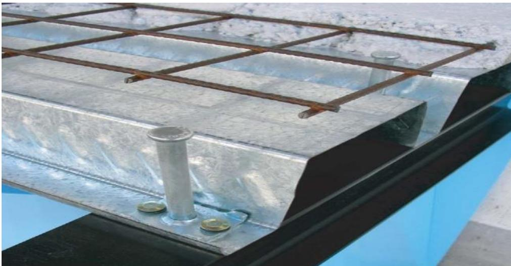
figure 3« Image d'un treillis soudé »
