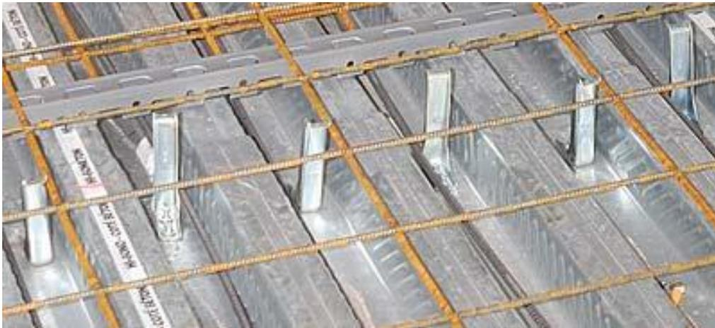
« Image d'un treillis soudé »
