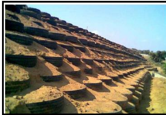
Figure I.10. Chantier expérimental Pneusol à Bou-Smail.
