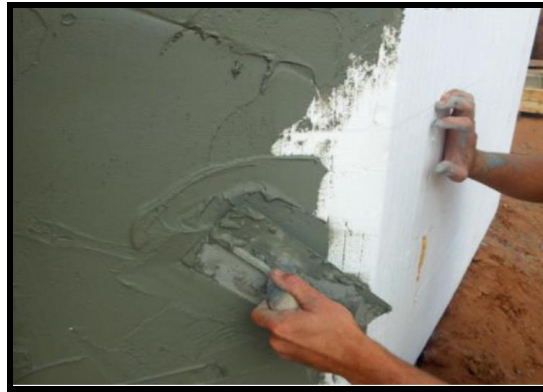
Figure I.3. Application d'enduit.
