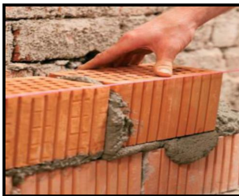
Figure I.2. Joints de maçonnerie.
