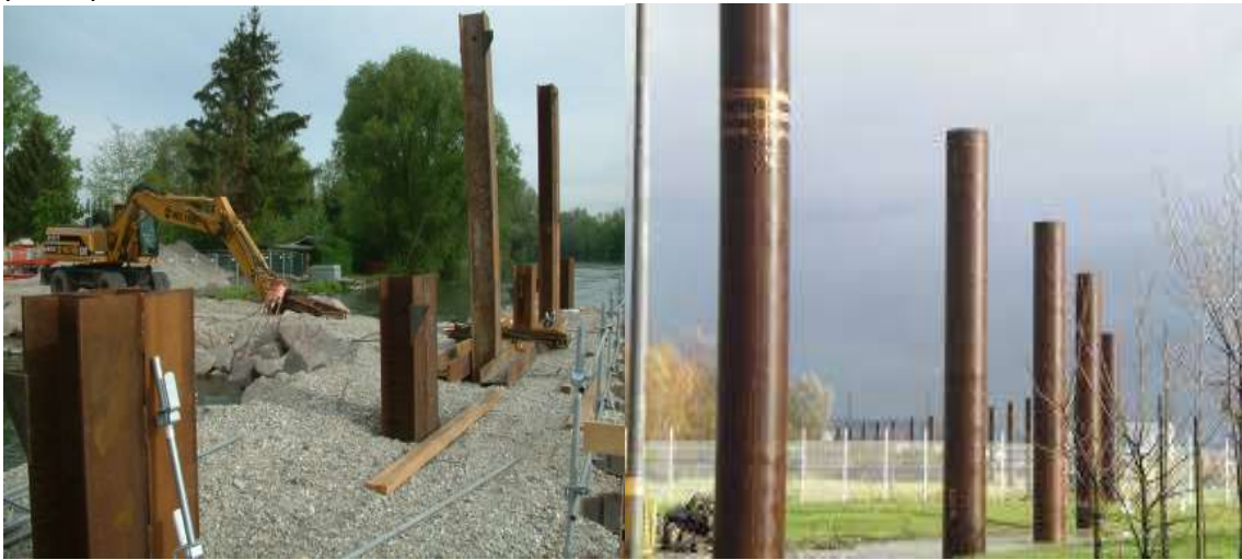
Figure I.9: pieu métallique forme H et tube
