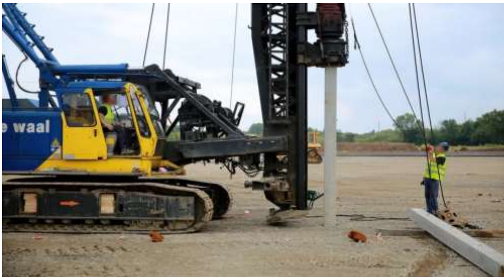
Figure I.12: Pieu battu préfabriqué
