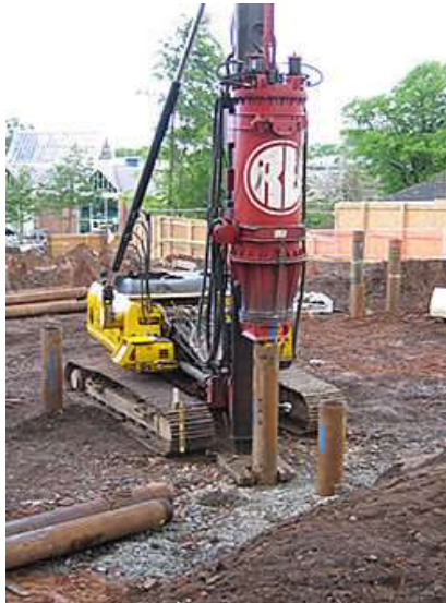
Figure I.13: Pieu en métal battu
