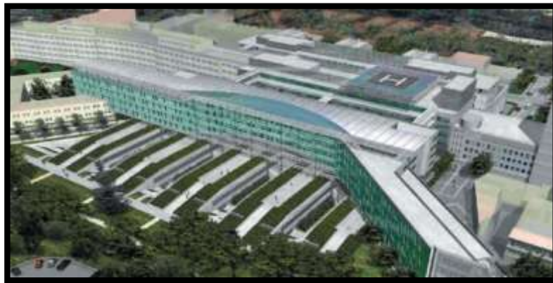
Figure 28: façade principale de l'hôpital
