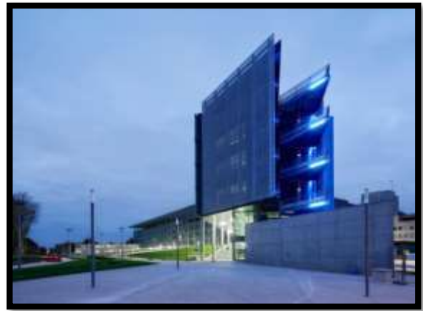
Figure 29:entrée vers le Hall d'accueil- angle sud est-
