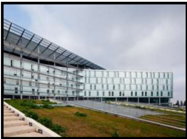
Figure 30:Façade sud, longue courbe sur 200m
