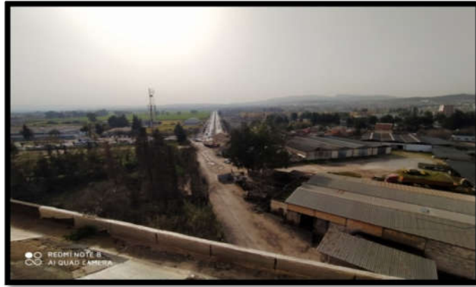
Figure 43 : photo aérienne des garages et dépôts.
