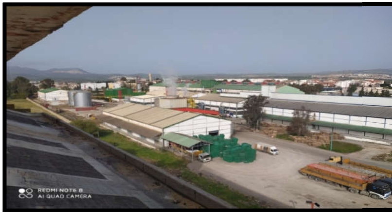
Figure 40 : photo de l'usine du sucre sur le site.
