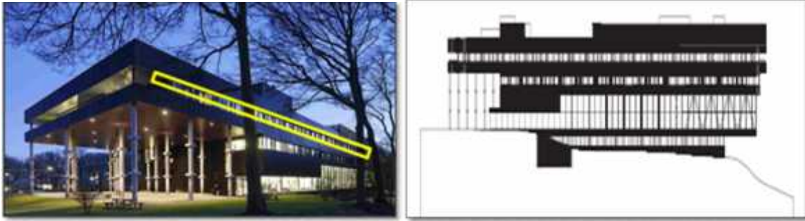
Figure 21 : Façade Ouest, Source : https://www.miesarch.com
