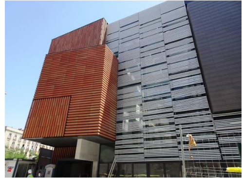
Figure 16: la façade latérale de l'école
