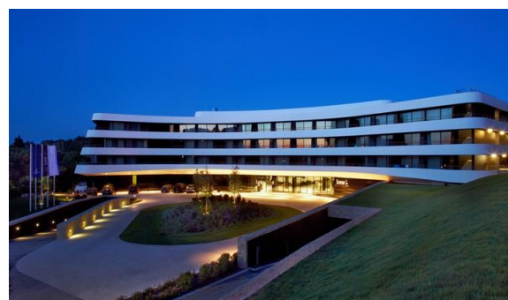
Figure 98: façades hôtel Lone
