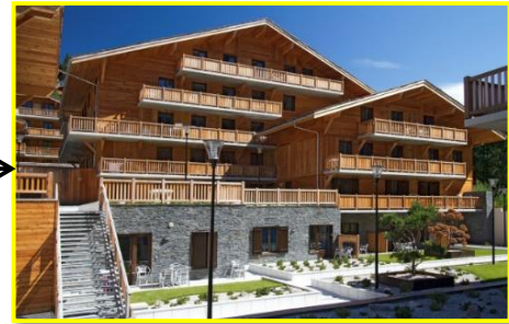
Figure 81: Bâtiment A de la résidence Mendi Alde
