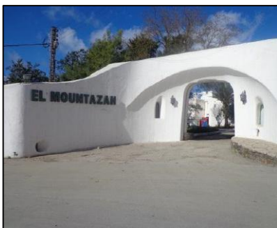
Figure 27: l'accès de l'hôtel
