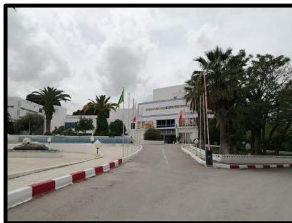
Figure 15 : Voies mécaniques vers bloc thermal. Source : personnel.
