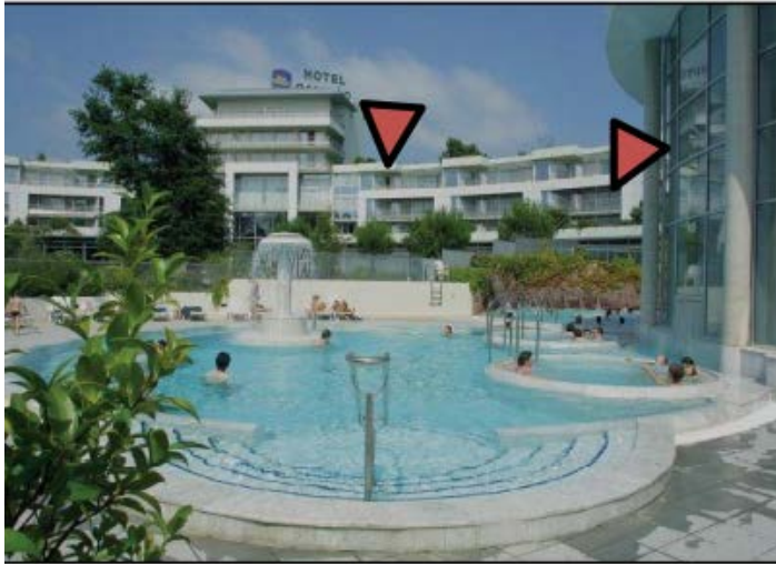
Figure 47: la façade d'hôtel.
