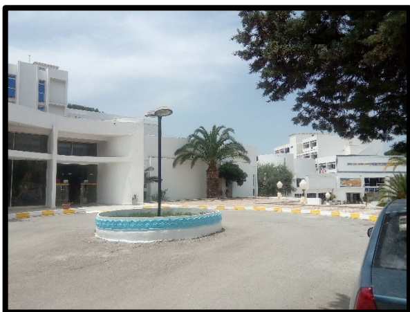
Figure 14 : Voies mécaniques vers bloc thermal. Source : personnel.
