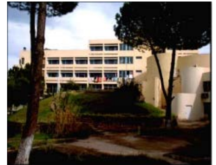
Figure 37: facade de l'hôtel . source : personnel .
