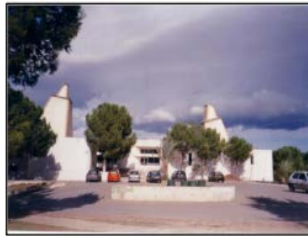
Figure 38 : façade principale . Source : Personnel.
