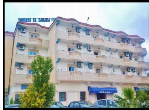
Figure 86: Figure : Le complexe thermal Bentboula à Héliopolis.
