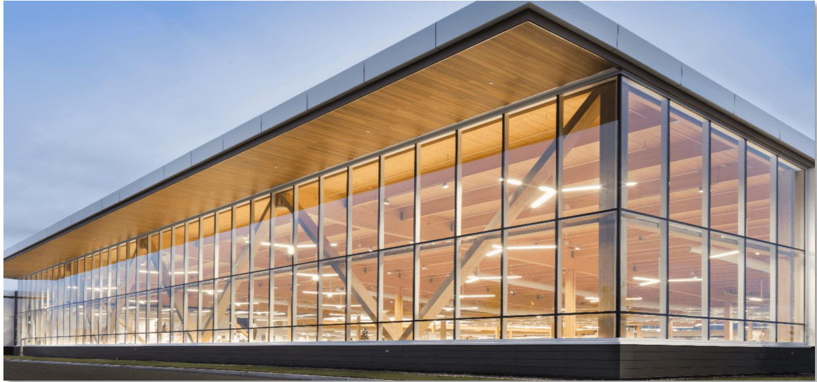
Figure 46 Structure en lamellée collé
