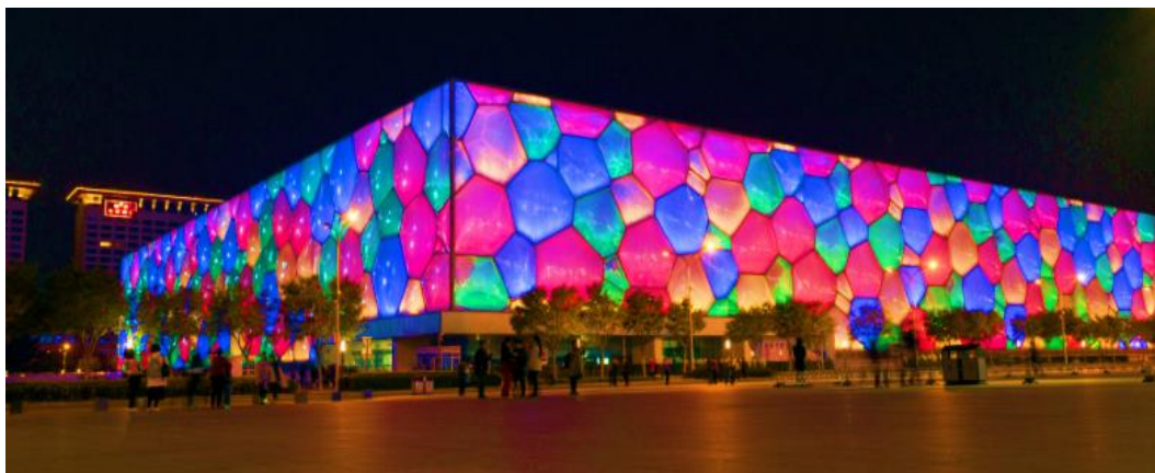
Figure 48 Atrium en ETFE
