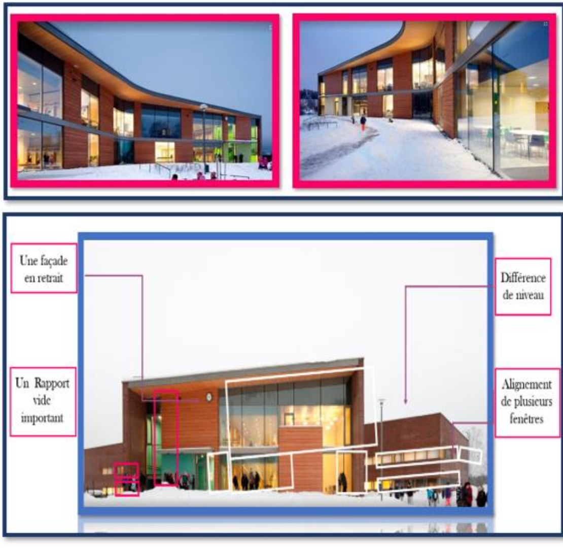
Figure 25 Façades du projet
