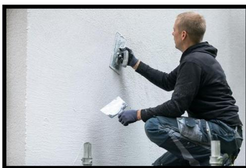
**Figure 137:** Enduit isolant : l'isolation thermique par l'extérieur simplifiée, Source: Google image
